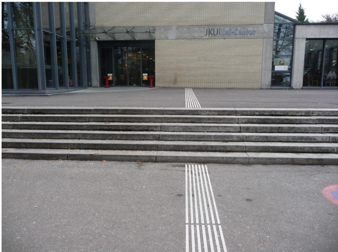
Abbildung 5: Bodenleitlinien am Campus der Johannes Kepler Universität Linz. Dass sie gegen die Wand laufen ist kein Streich, sich an der Wand entlangzutasten ist gewünscht.
